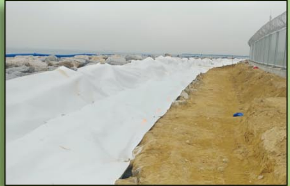
Non-Woven Geotextile Seawall Fill Separation 比利時土工布分隔海堤填料
