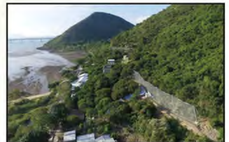
8,600 kJ Flexible barrier, Shum Wat, Lantau, Jan 2014 深屈8,600千焦耳檔石網
