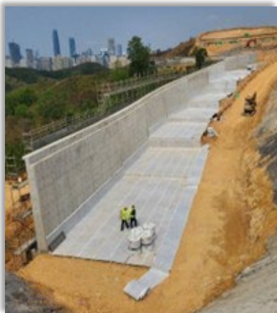
擋土牆排水，缸瓦甫警察設施 2021年3月 (ND/2018/01)
