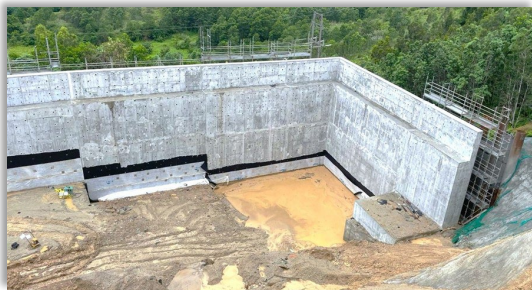
擋土結構排水，新界東北堆田區擴建 2024年5月 (EP/SP/77/15)
