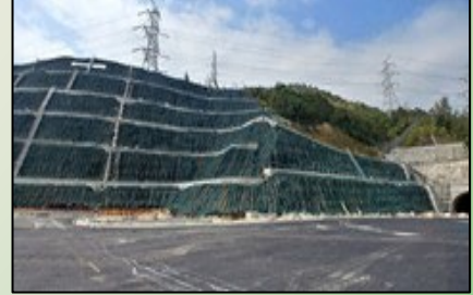
侵蝕控制屯門-赤鱗角連接路 2018年3月
