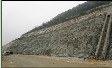
侵蝕控制, 安達臣道石礦場 2019年3月
