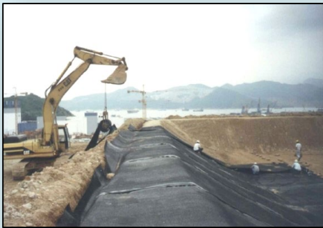
東南堆填區, 2001年12月
